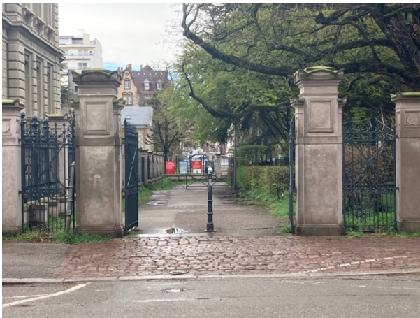
L'allée avant travaux
